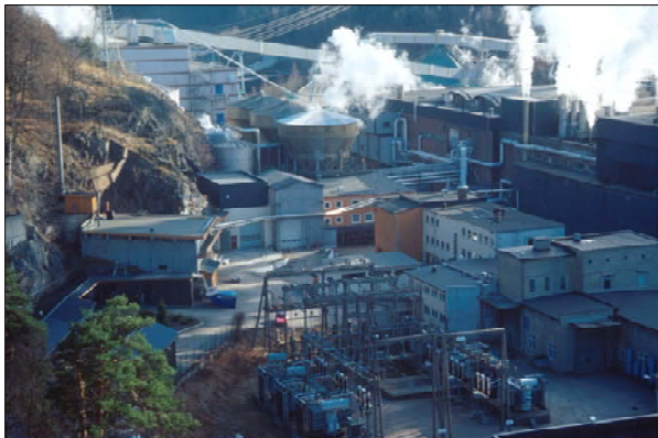
Haldenreaktoren har en sentral beliggenhet i Halden sentrum, og forsyner lokal industri med damp. Foto: Erik Martiniussen/ Bellona
