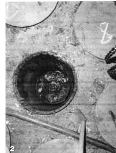
хватили, сказали: «Ваши собственные руки являются хорошими орудиями производства». Не было никаких технических средств, даже отбойных молотков. Ведь предстояла трудная, тупая работа. Необходимо было практически голыми руками разбить бетонные пробки на трех емкостях толщиной в полметра и диаметром 18 м.
