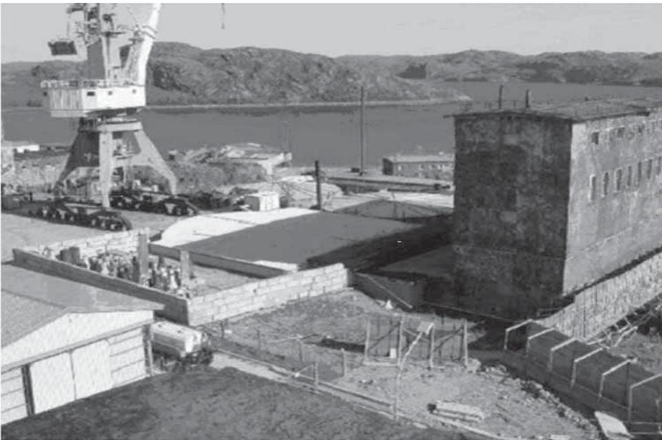
Панорама на БСХ. Справа здание №1 огороженое забором. Слева от здания вдали две емкости 2А и 2Б. Ближе к крану емкость 3А накрыта новой крышей. Слева от емкости 3А площадка с контейнерами. Вдали виден причал с которого планируется вывозить отработавшее топливо.
