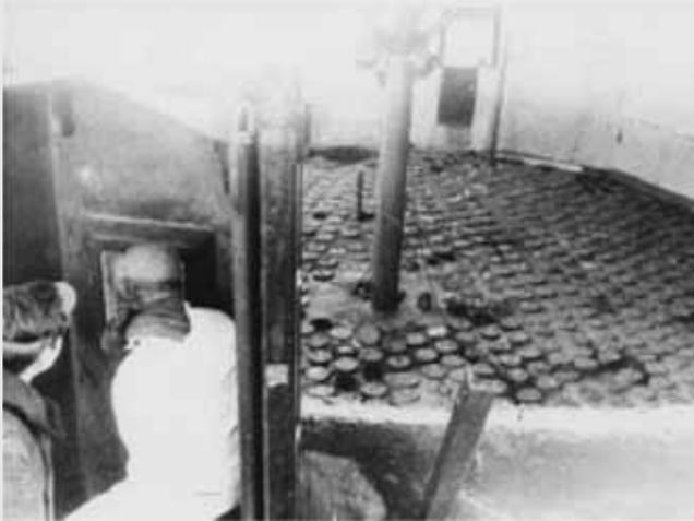
*Для загрузки емкостей 2А и 2Б использовали защитный экран. Однако затем выяснили, что отраженные от стен хранилища гамма-излучения облучало людей, спрятавшихся за экраном, сзади*
